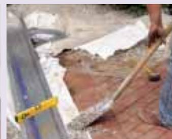
Ganz wichtig ist die waagerechte Ausrichtung des Systems – prüfen Sie unbedingt in beide Richtungen, ob die Bachlaufelemente in Waage sind. Danach kann die Randgestaltung vorgenommen werden – fertig!
