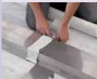
Legen Sie die Elemente auf den Kopf gedreht passend aneinander. Dann wird der Verbindungstreifen aufgeklebt.
