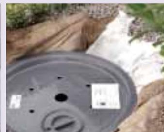
Das Wasserreservoir wird idealerweise am Kopfende des Startelements platziert und sollte versteckbar, aber zugänglich sein. Die Schläuche werden einfach entlang der Bachlaufelemente in das Kiesbett verlegt.
